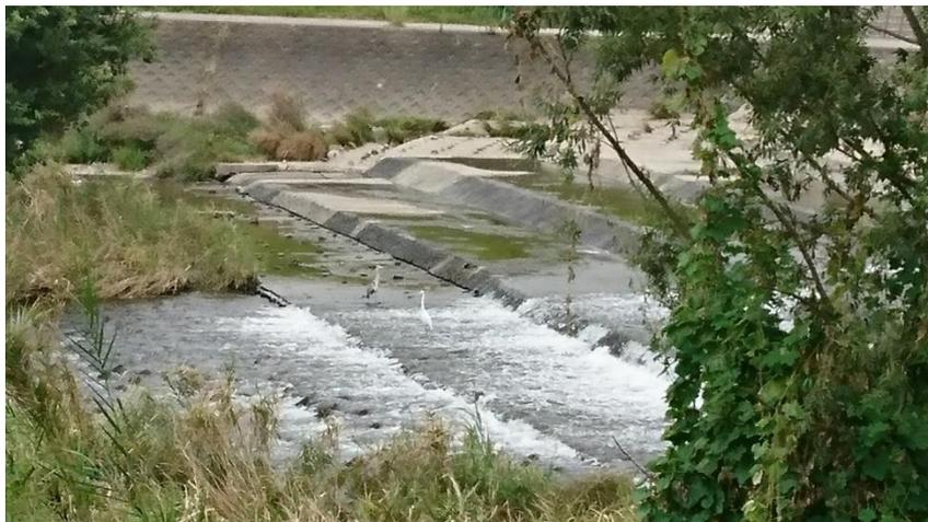
藻川側にある大井堰だが、下流部は階段状に傾斜が出来ているので魚の遡上、流下は可能な構造だ。堰ではアオサギ等が狩りをしていた
