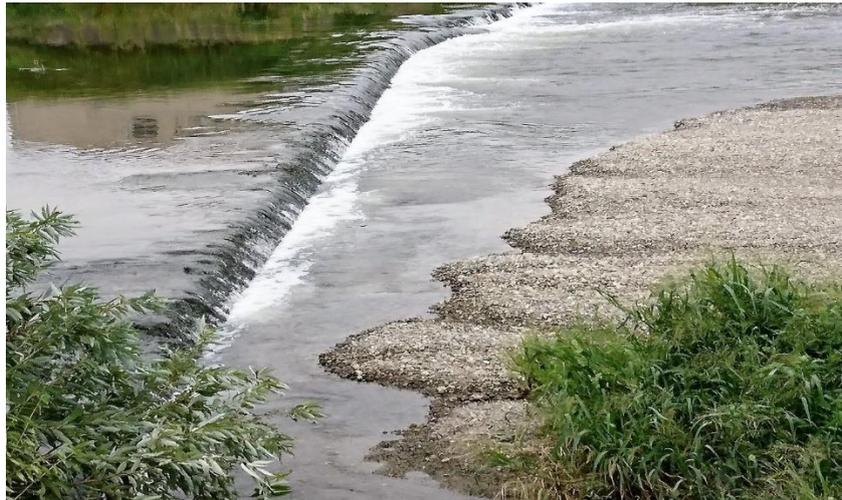
猪名川側にある堰だが、現在では下流側が土砂で埋まって大きな段差は無く魚は自由に移動できる状態だ。以前はもっと段差があったように記憶している
