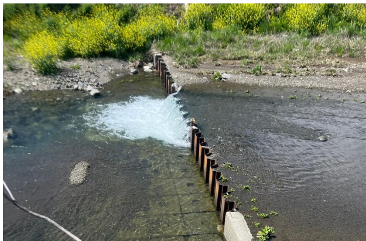
←正常な落差工
